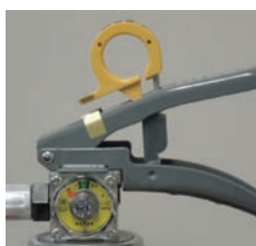
× 安全栓の抜けかけ
