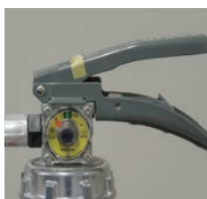
× 安全栓の脱落
